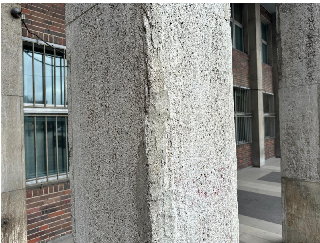
Fot. 75. Okładzina kamienna (trawertyn) elewacji budynku. Widoczne uzupełnienia kamienia i spoin.
