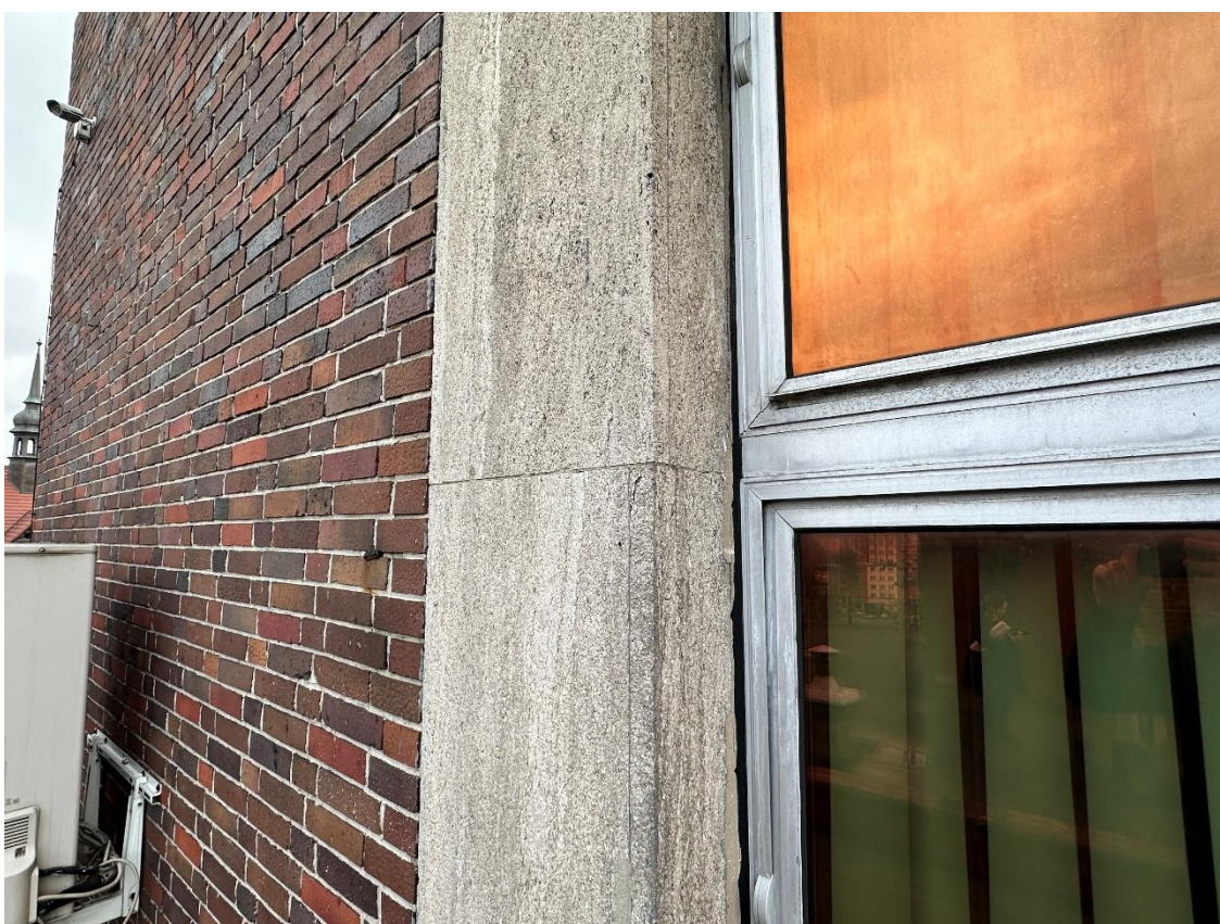
Fot. 81. Okładzina kamienna (trawertyn) elewacji budynku. Widoczne zabrudzenia powierzchni kamienia.
