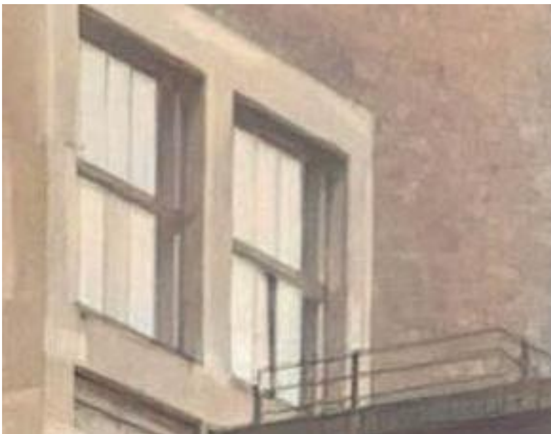
Fot. 57. Fotografia archiwalna. Widoczne dodatkowe otwieranie okna w postaci uchylnej środkowej kwatery w dolnym skrzydle.
