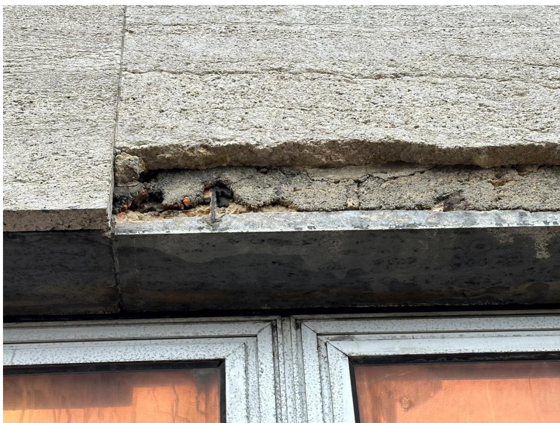
Fot. 79. Okładzina kamienna (trawertyn) elewacji budynku. Widoczne ubytki kamienia.
