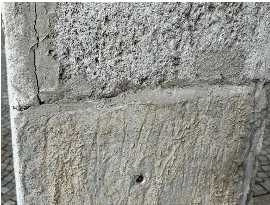
Fot. 73. Okładzina kamienna (trawertyn) elewacji budynku. Widoczne uzupełnienia kamienia i spoin.
