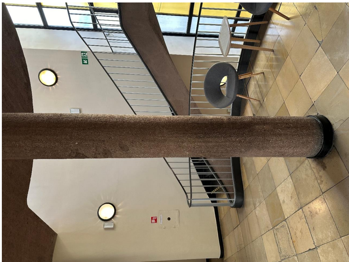
Fot. 111. Główna klatka schodowa. Sufit i kolumna z betonu naturalnego.
