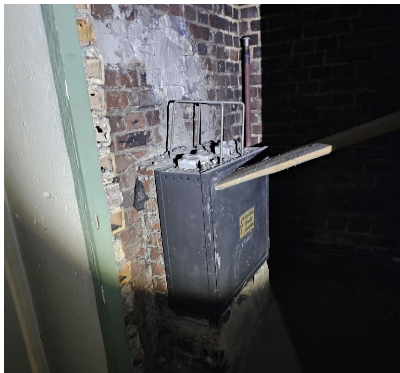
Fot. 140. Zachowana rozdzielnia elektryczna.
