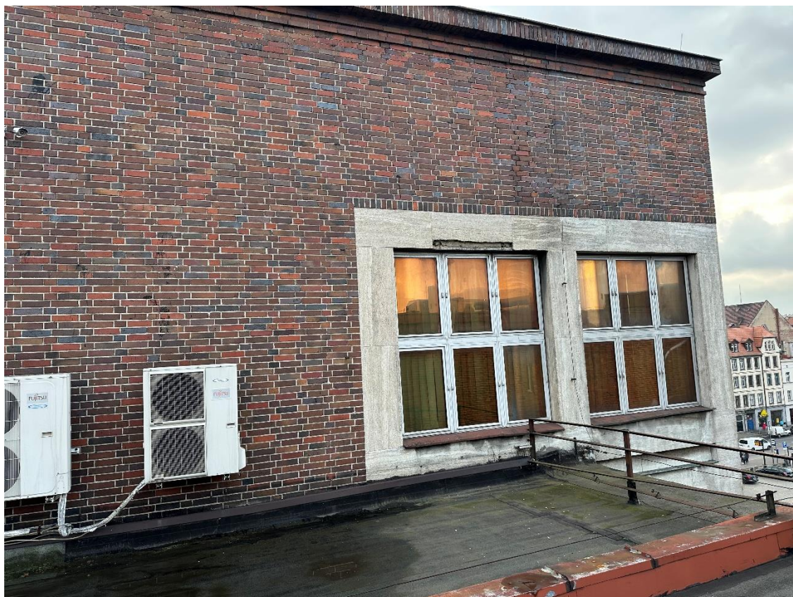
Fot. 78. Okładzina kamienna (trawertyn) elewacji budynku. Widoczne ubytki kamienia.
