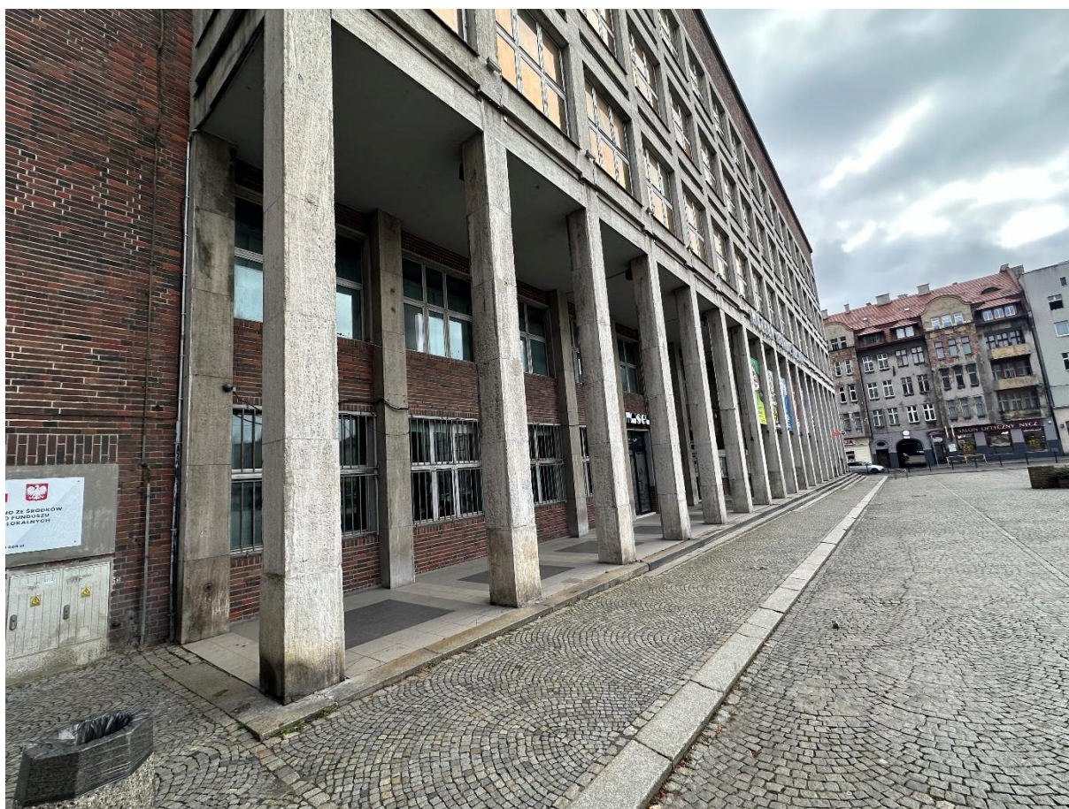
Fot. 68. Okładzina kamienna (trawertyn) elewacji budynku.
