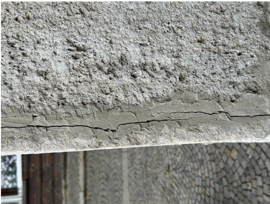
Fot. 72. Okładzina kamienna (trawertyn) elewacji budynku. Widoczne odspojenia kamienia.
