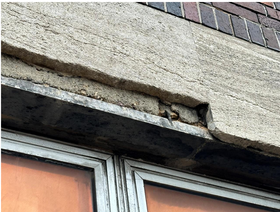
Fot. 80. Okładzina kamienna (trawertyn) elewacji budynku. Widoczne ubytki kamienia.
