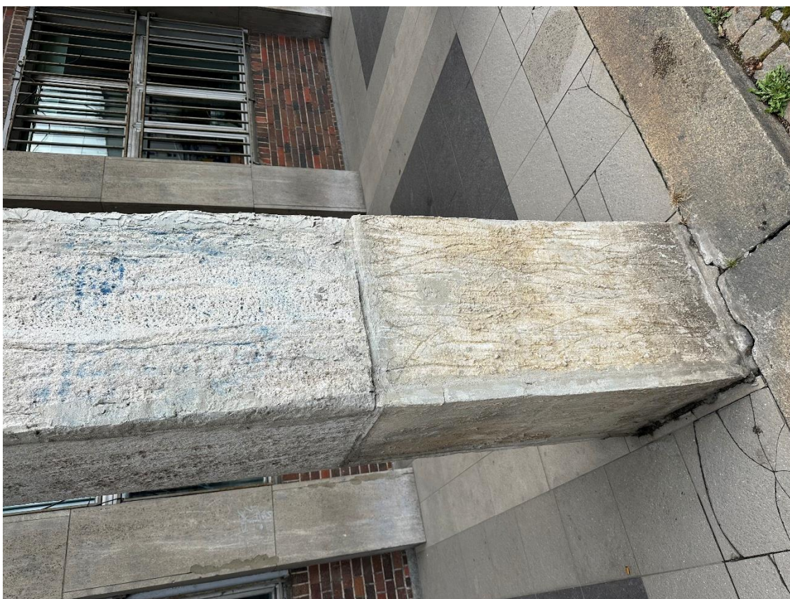
Fot. 71. Okładzina kamienna (trawertyn) elewacji budynku. Widoczne uzupełnienia kamienia i spoin.
