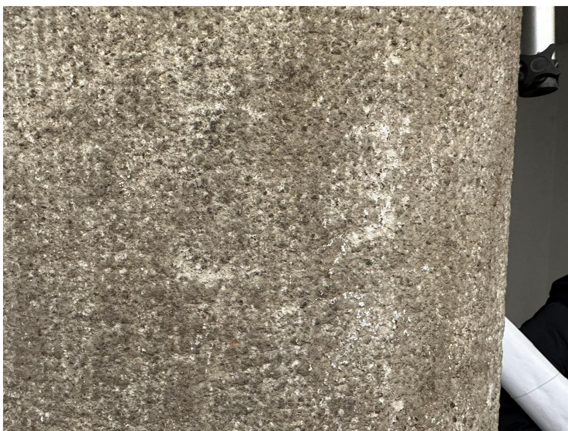
Fot. 114. Główna klatka schodowa. Kolumna z betonu naturalnego.
