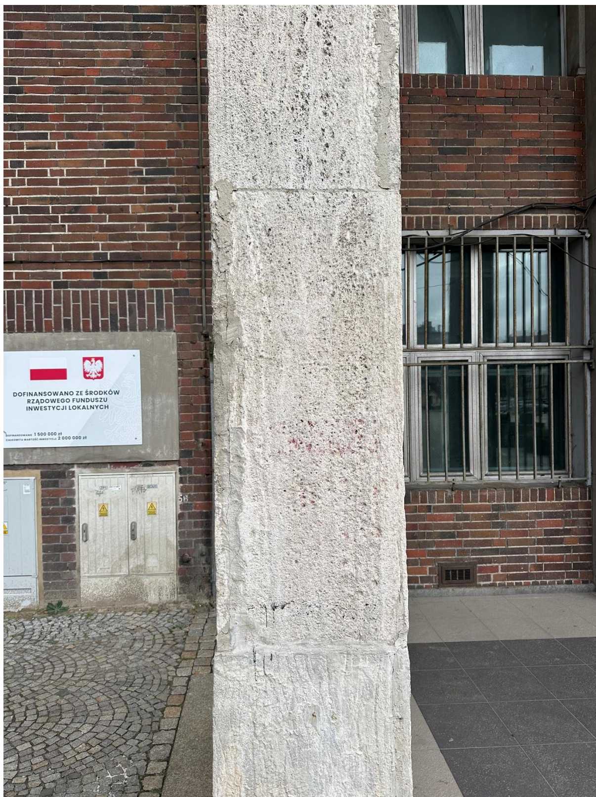
Fot. 69. Okładzina kamienna (trawertyn) elewacji budynku. Widoczne uzupełnienia kamienia i spoin.
