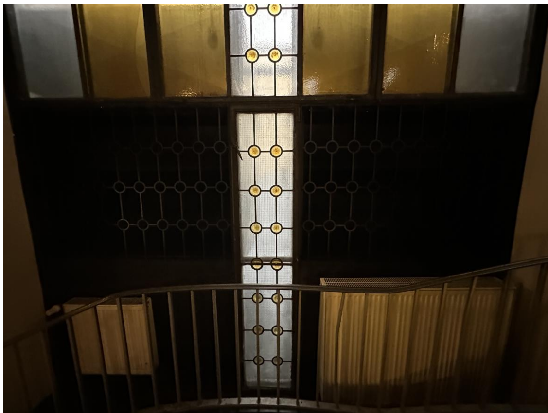
Fot. 117. Ślusarka okienna klatki schodowej.
