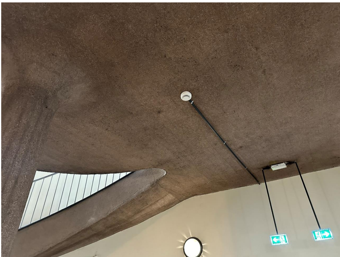
Fot. 109. Główna klatka schodowa. Sufit z betonu naturalnego.
