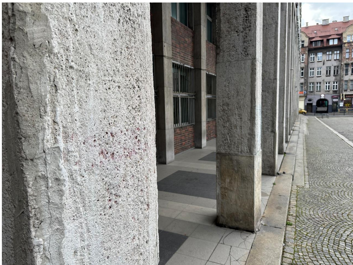
Fot. 76. Okładzina kamienna (trawertyn) elewacji budynku. Widoczne uzupełnienia kamienia i spoin.
