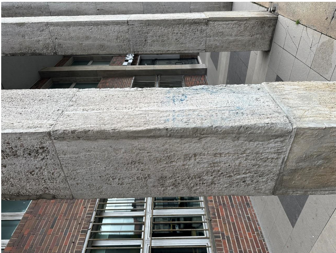
Fot. 70. Okładzina kamienna (trawertyn) elewacji budynku. Widoczne uzupełnienia kamienia i spoin.
