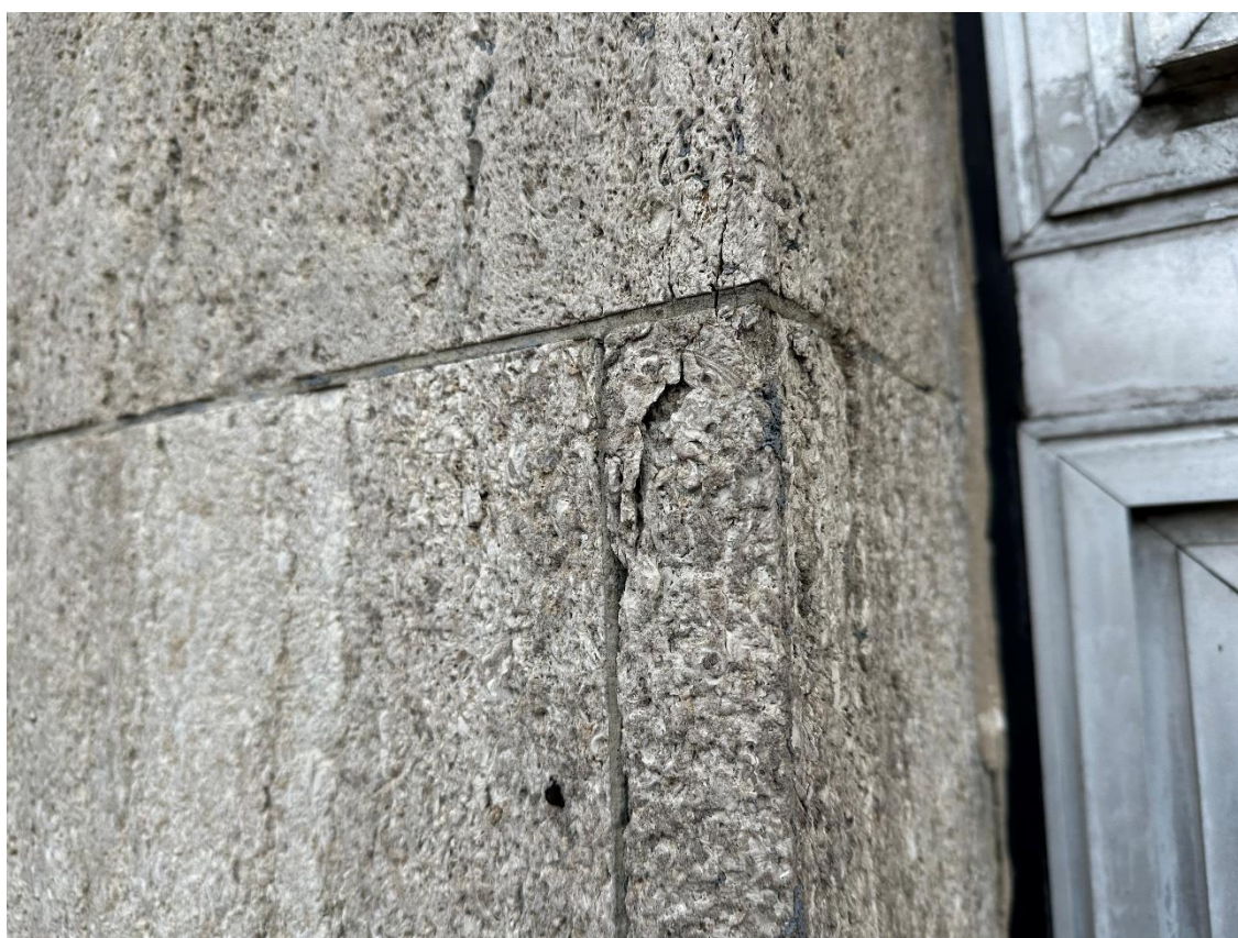
Fot. 77. Okładzina kamienna (trawertyn) elewacji budynku. Widoczne pęknięcia kamienia.
