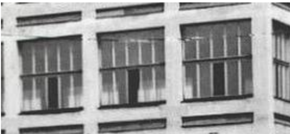
Fot. 57. Fotografia archiwalna. Widoczne dodatkowe otwieranie okna w postaci uchylnej środkowej kwatery w dolnym skrzydle.
